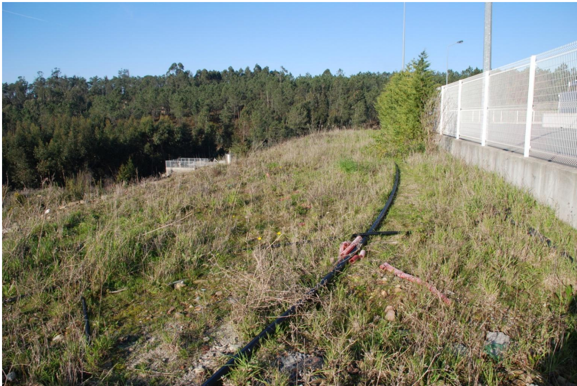
Fotografia 8 – Parte superior do talude
