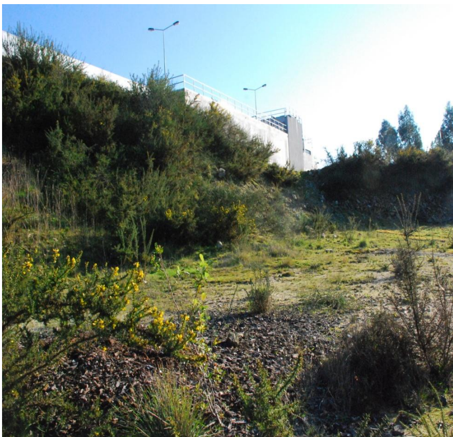
Fotografia 10 – Visualização da área a ser afectada pela intervenção
