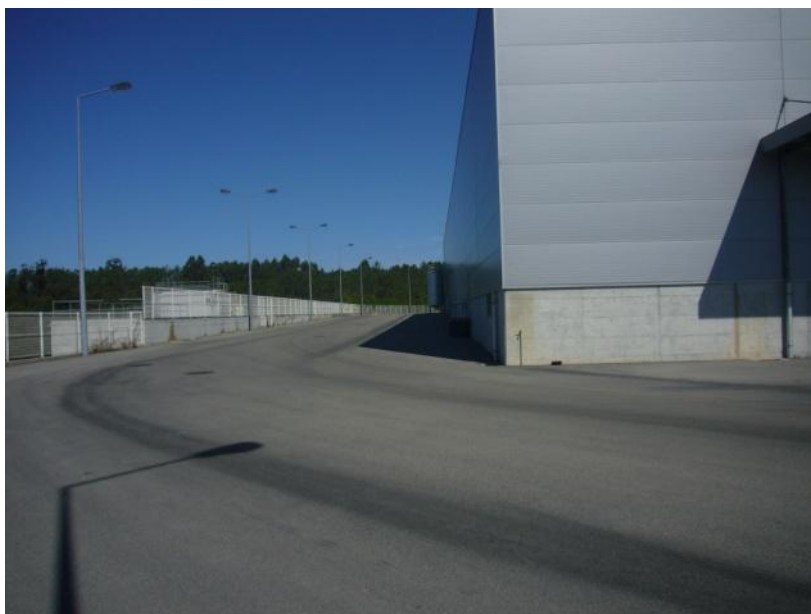
Fotografia 22 - Vista pormenorizada da fachada Oeste da nave industrial existente, a partir do interior do Centro de Recolha de Leite – LEICARCOOP – Situação actual
