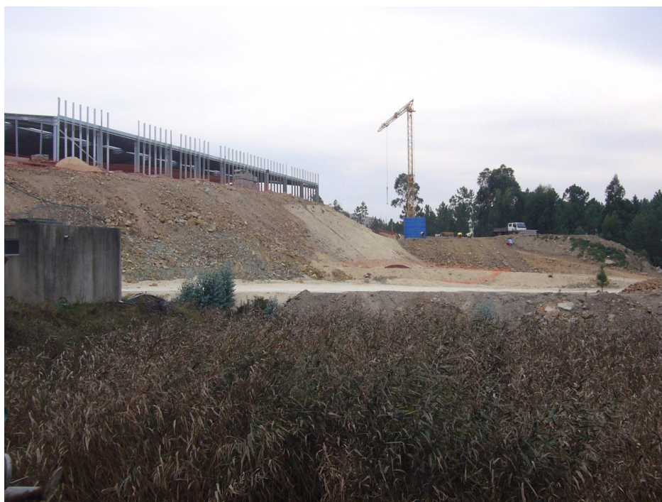
Fotografia 2 – Visualização da estruturação do talude aquando das obras de construção do Centro de Recolha de Leite (Fotografia capturada no ano de 2007)
