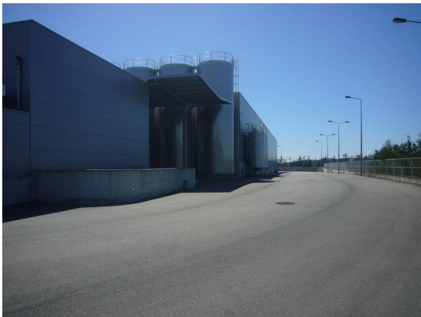
Fotografia 23 - Vista da fachada Oeste do Centro de Recolha de Leite, com visualização do espaço destinado a materiais de limpeza e higienização – LEICARCOOP– situação actual
