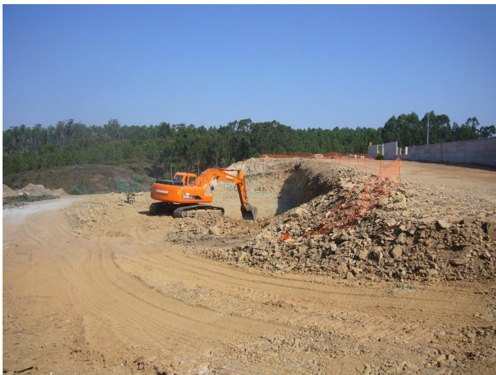
Fotografia 1 – Escavações decorrentes da construção do Centro de Recolha de Leite, necessárias para implantação da ETA e ETAR existentes (Fotografia capturada no ano de 2007)
