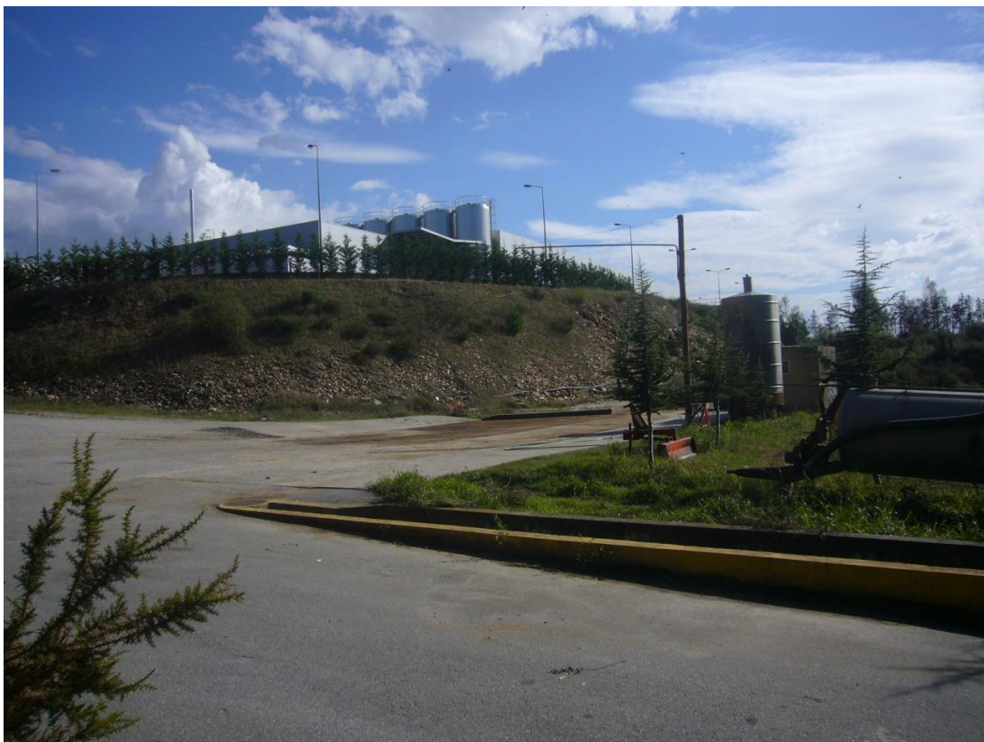
Fotografia 7 – Perfil Noroeste do talude
