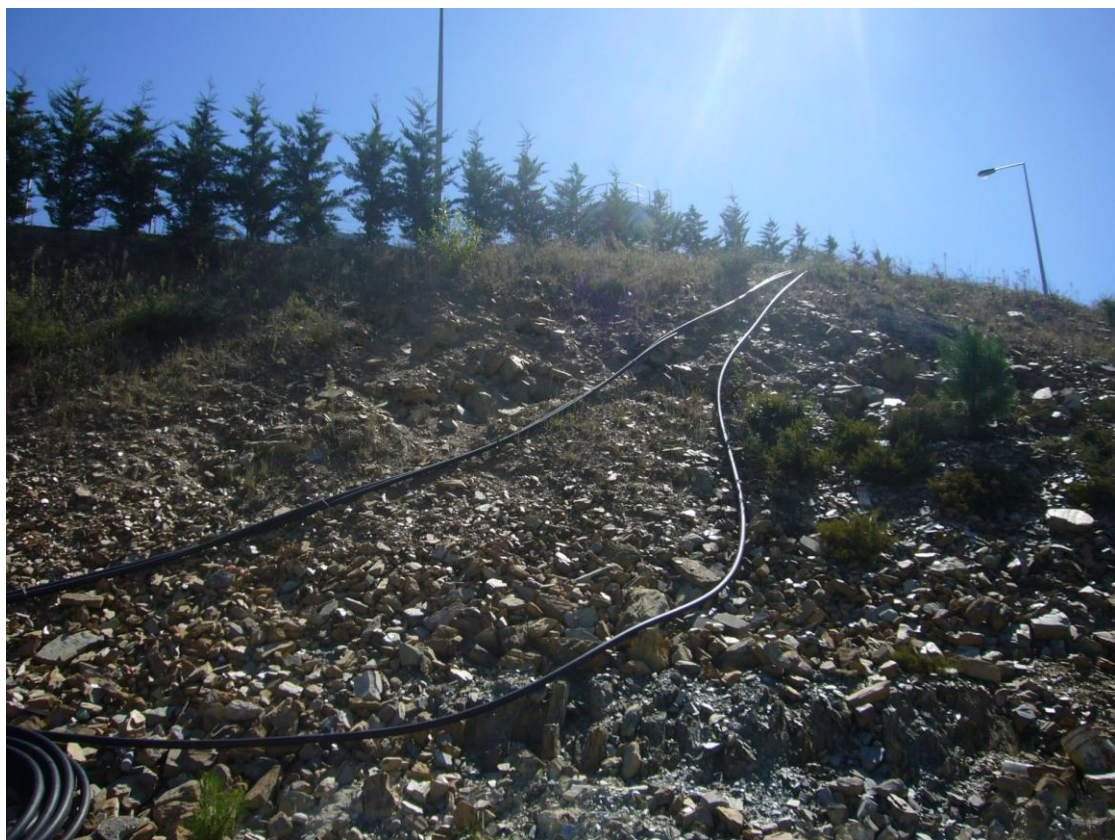
Fotografia 9 – Pormenor do talude
