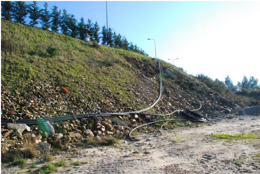
Fotografia 6 – Perfil Norte do talude
