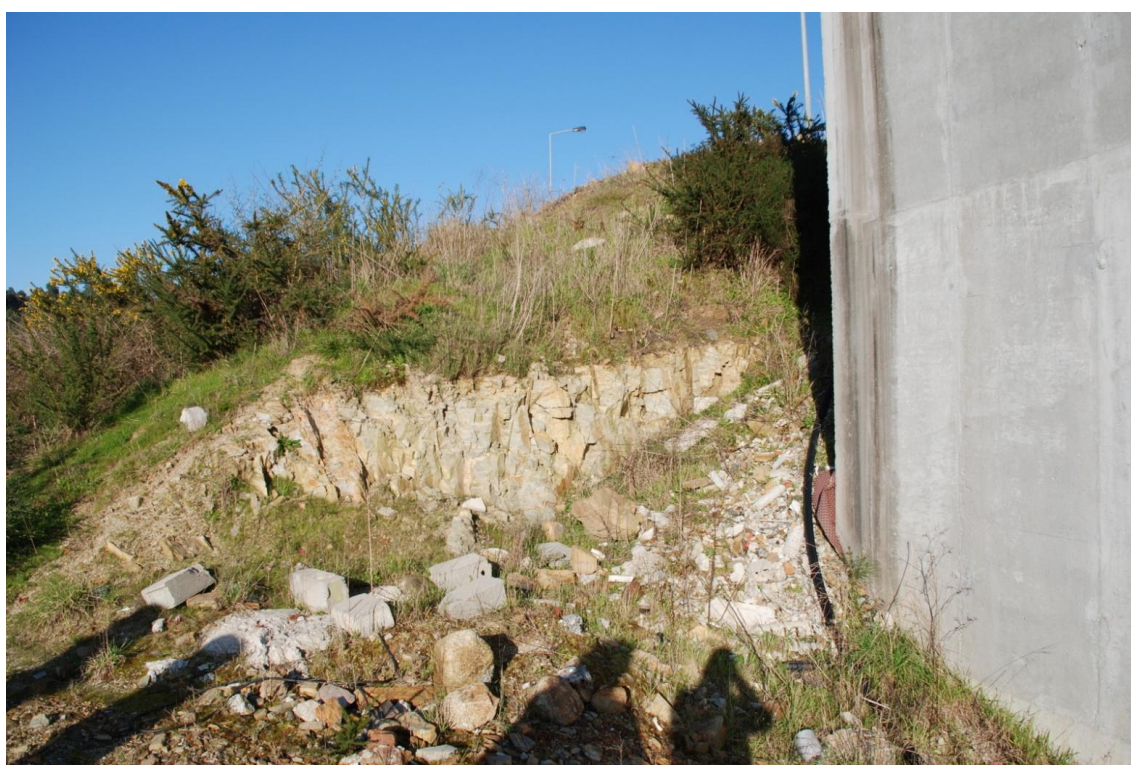
Fotografia 5 – Perfil Sul do talude
