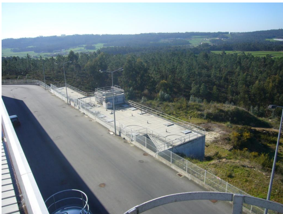
Fotografia 21 - Vista panorâmica da ETA e da ETAR a partir do interior do Centro de Recolha de Leite – LEICARCOOP- situação actual
