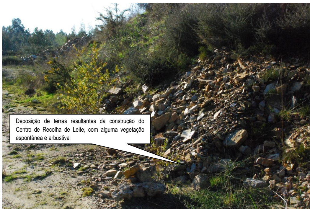
Fotografia 12 – Pormenor da área circundante ao talude
