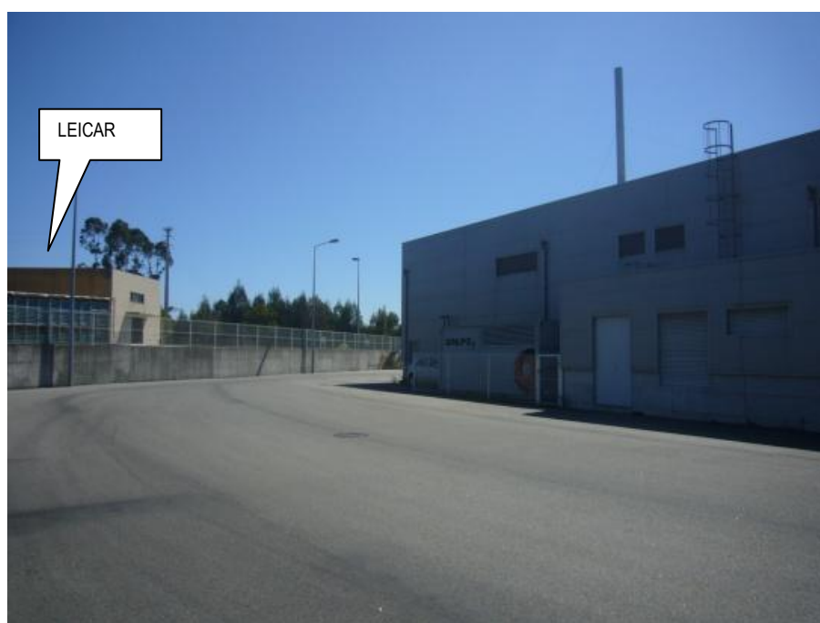
Fotografia 26 -Vista a partir do interior do Centro de Recolha de Leite – LEICARCOOP, com visualização da fachada Norte da unidade em estudo - situação actual
