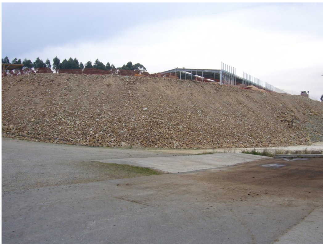
Fotografia 3 – Perfil Norte e Poente do talude, a intervencionar para a ampliação da ETA e ETAR existentes, aquando da construção do Centro de Recolha de Leite (Fotografia capturada no ano de 2007)
